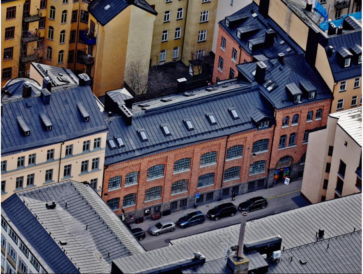
Kapsylfabrikens norrfasad med sine ateljéer
